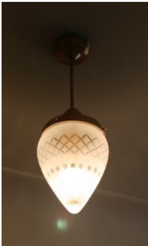
Entréarmatur och trapphus
